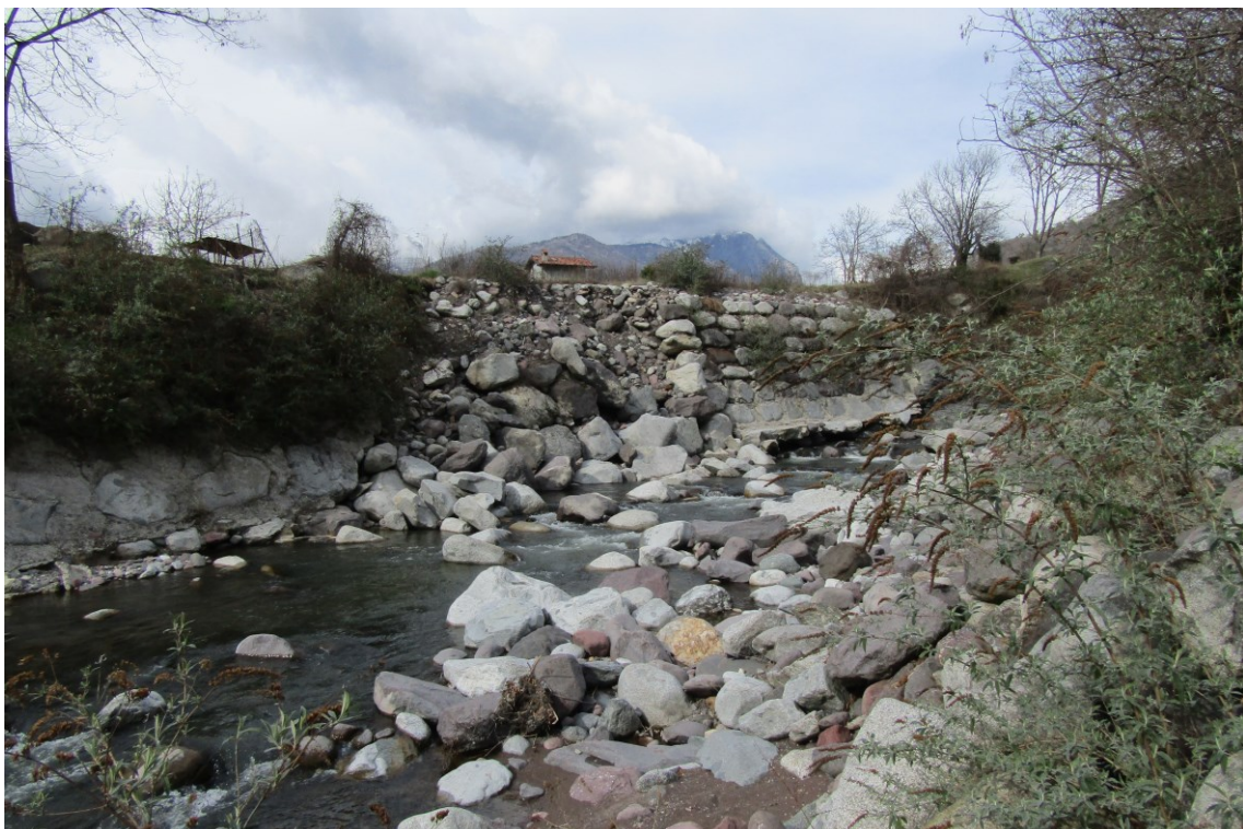
Particolare della scogliera danneggiata posta lungo la sponda destra in corrispondenza della parte inferiore dell'area in esame.
